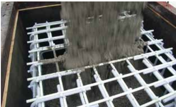
Transformer foundation Peiner Träger Ltd., Peine, Germany
