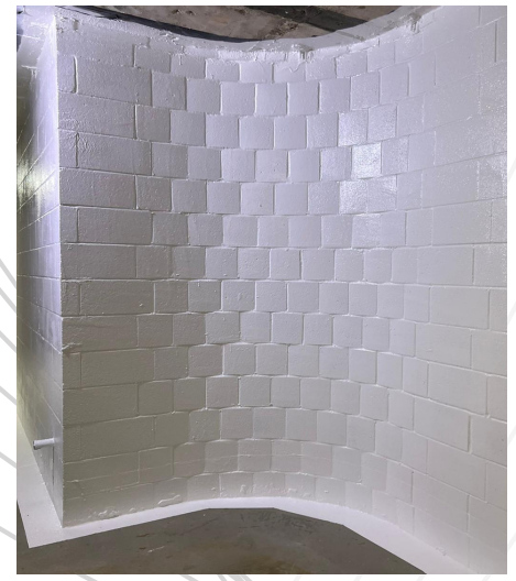
5.1.4 Airtight White retrofit
