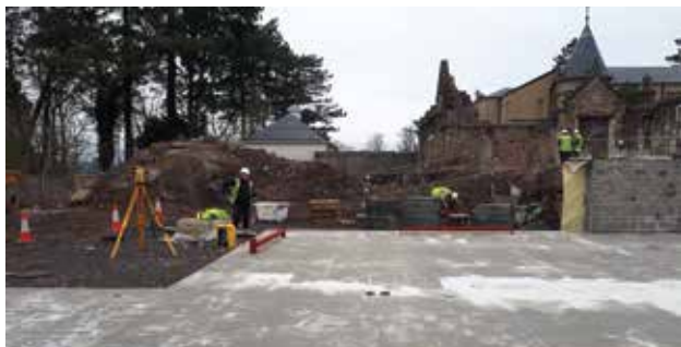
DELTA DUALPROOF POST CONCRETE POUR
